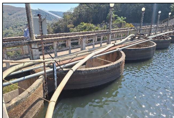
Estação fluviométrica/pluviométrica PCH Rio de Pedras – Barramento e régua linimétrica. Autoria: Luísa Mosqueira Data: 14/08/2024
