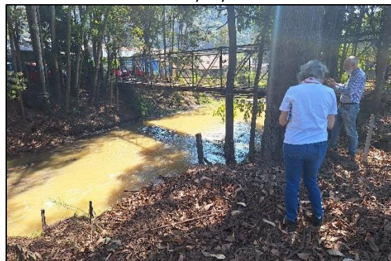
Avaliação das condições das réguas linimétricas da PCH Rio das Pedras – Rio Itabirito.
